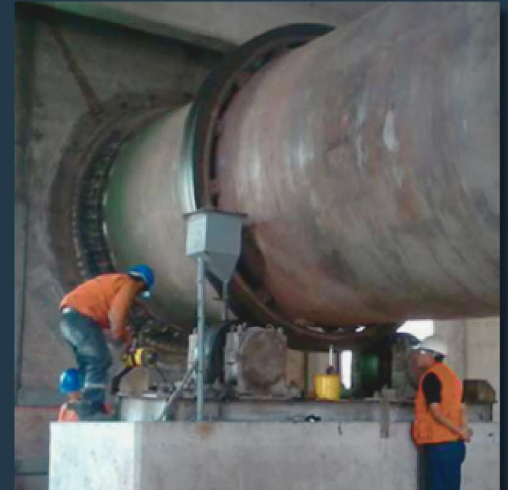
Montaje de polines y molinos de bolas
