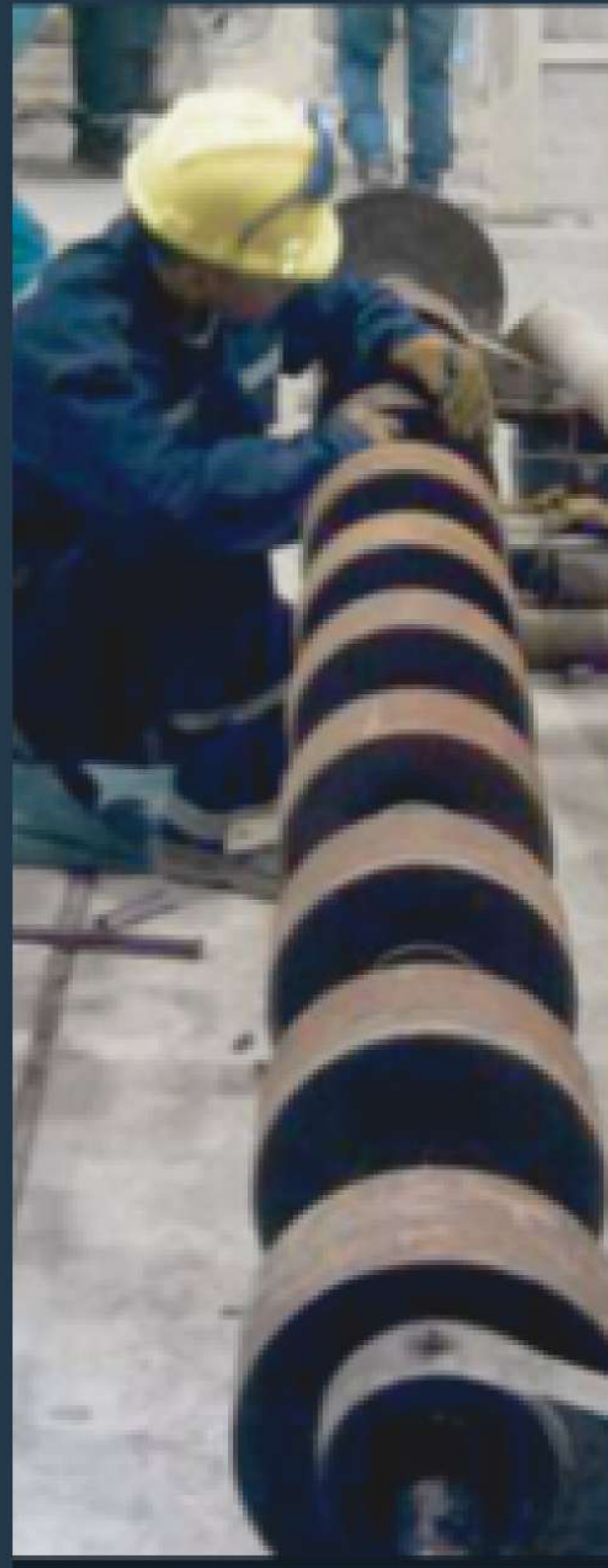
Montaje de fajas transportadoras.
